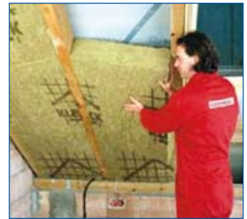
Steinwolle im Dachbereich
