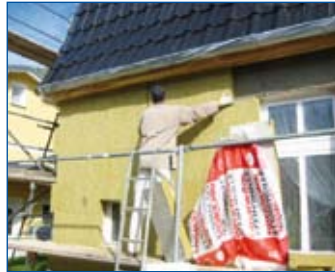
Steinwolle an der Außenwand
