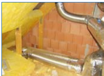
Einbau der Wohnungslüftungsanlage
